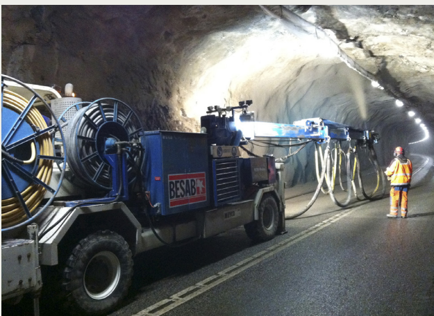
Bild 4. Betongsprutning i väg tunnel.
