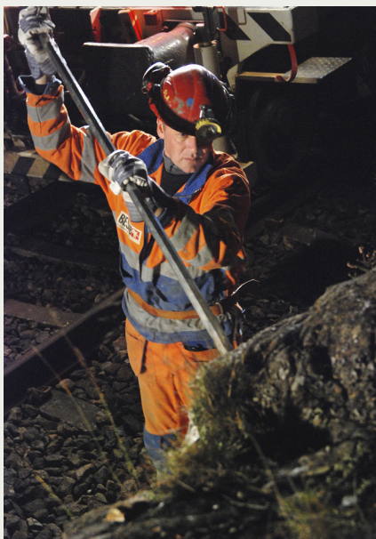
Bild 3. Manuell skrotning.
