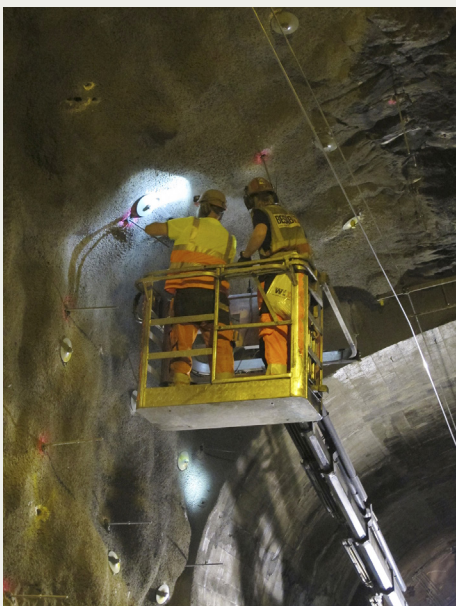
Bild 2. Förberedelse för dränmontage i spår tunnel.
